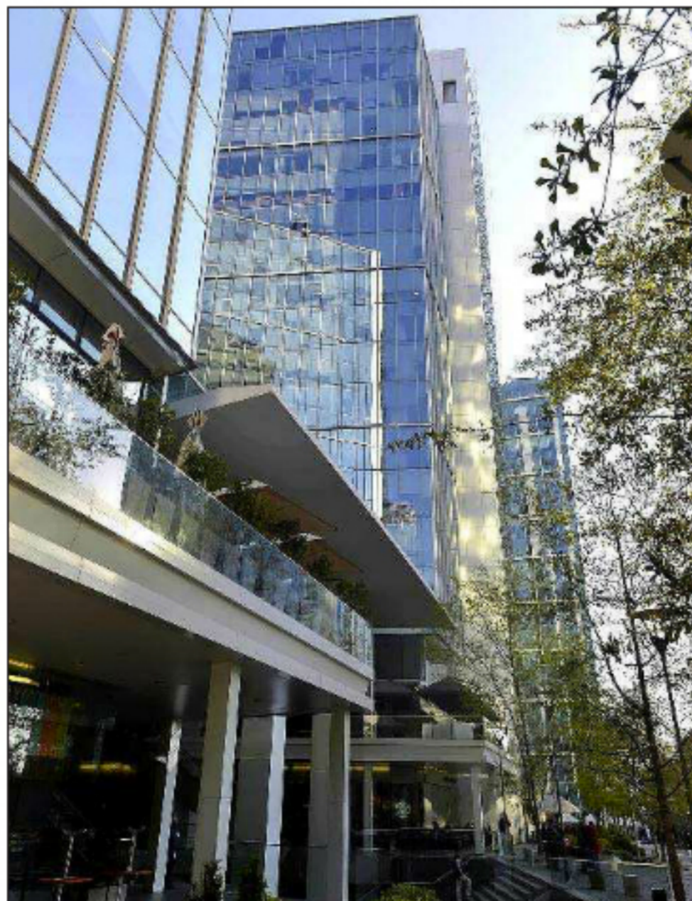
EDIFICIO.— El edificio está en el barrio de Nueva Las Condes, en Cerro El Plomo 5680, y consta de 12 pisos, con más de 16 mil metros cuadrados.
